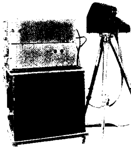
La telecamera di Zworykin. Si noti che essa ha l'aspetto e le dimensioni di una comune macchina cinematografica. Dentro di essa si trova il tubo catodico speciale: 'iconoscopio' e il primo amplificatore. Il complesso di sinistra comprende il secondo amplificatore e i generatori degli impulsi sincronizzanti per la deviazione orizzontale e verticale del fascio catodico.
