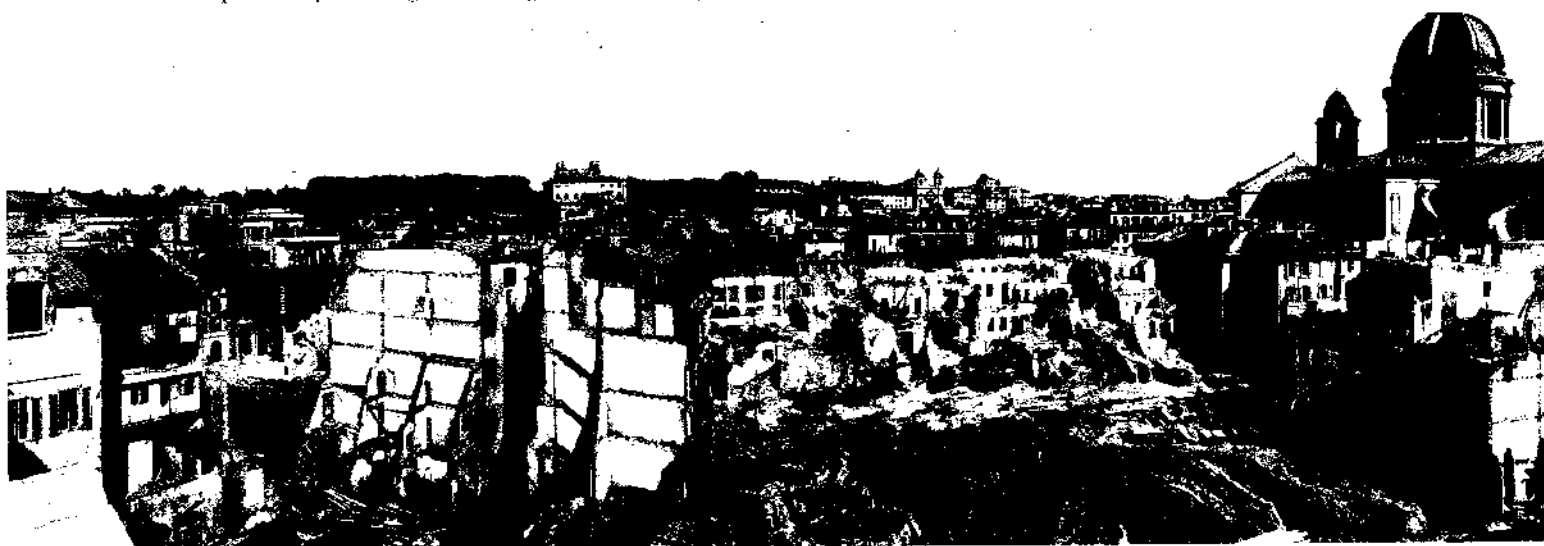
I lavori di demolizione per l'isolamento del Mausoleo di Augusto.
