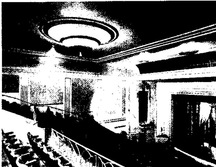
Anche fra le pareti laterali, immediatamente vicino allo schermo, possono determinarsi riflessioni dannose alle onde sonore. Perciò esse vengono rivestite con pannelli di materiale assorbente che si presta anche a scopi decorativi.
