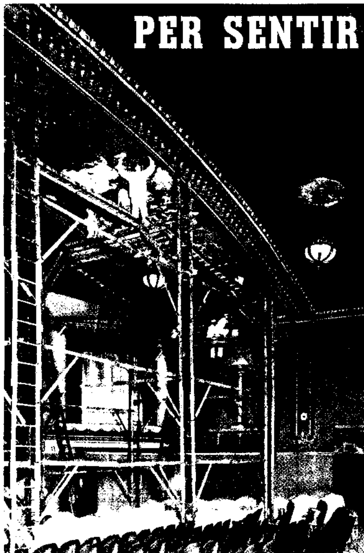
Correzione acustica delle sale di proiezione. - Prima di applicare il rivestimento di materiale assorbente le pareti vengono preparate in modo speciale.
