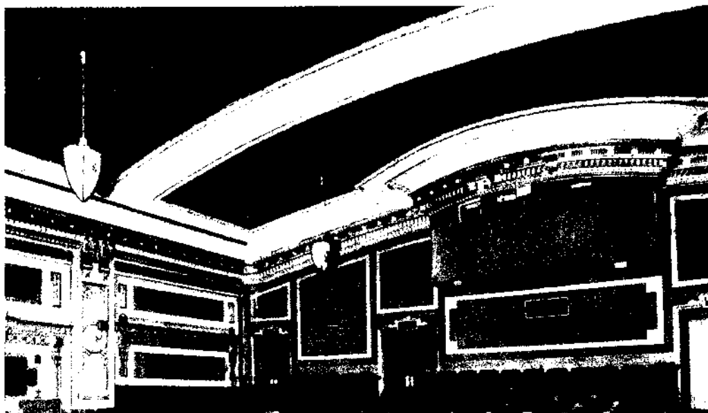
Un Cinema di Chicago. Tutte le pareti e il soffitto sono tappezzati di materiale acusticamente assorbente. Si evitano così completamente i dannosi effetti delle riflessioni del suono specialmente nel soffitto leggermente incurvato e sulla sporgenza della cabina di proiezione.
