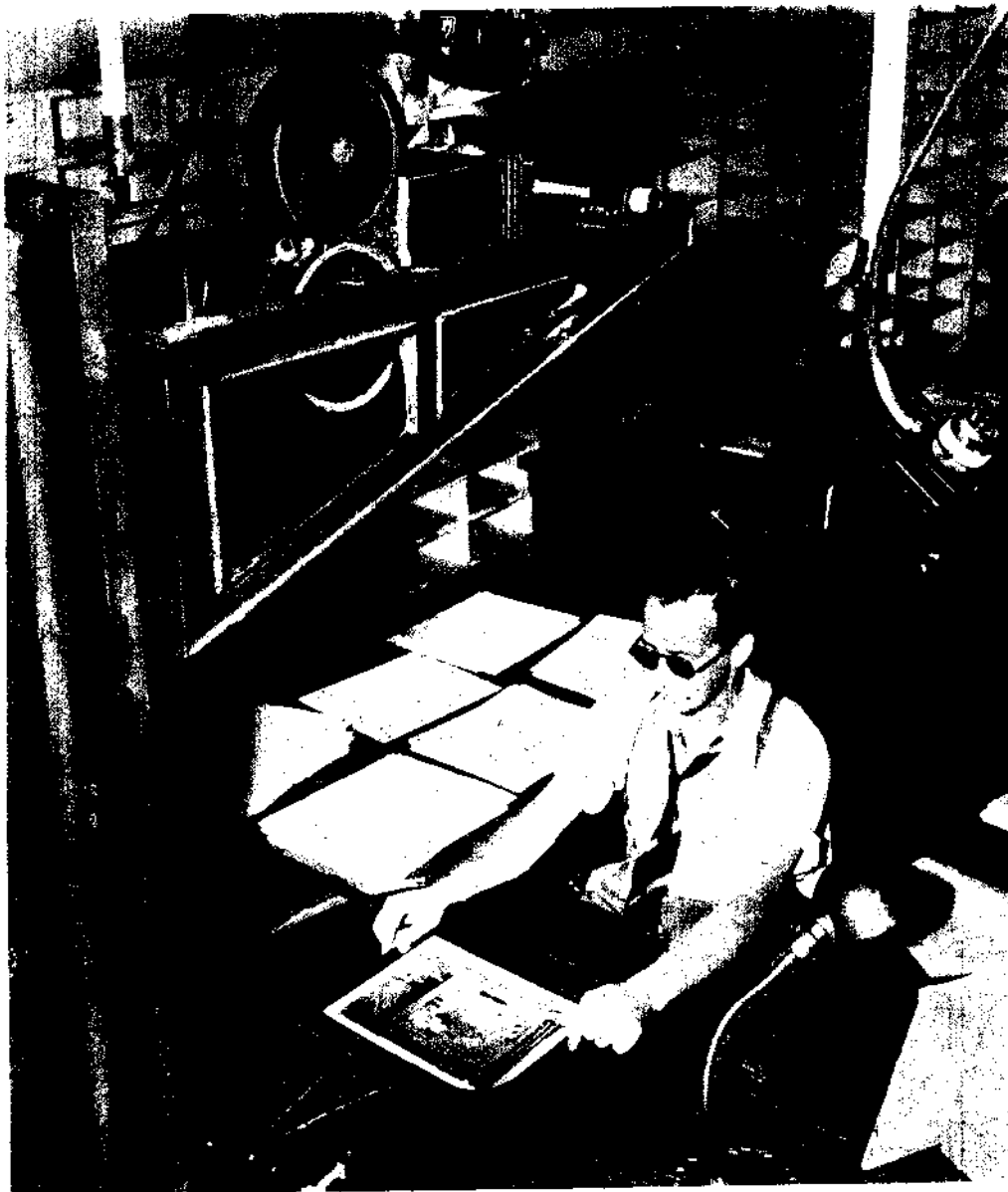
La macchina da presa che fotografa, dall'alto, i disegni da animarsi
