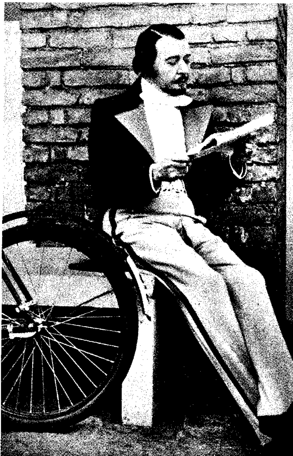
Georg Alexander è uno che crede nei critici e non può fare a meno di leggere ciò che essi scrivono neanche nei momenti di pausa
